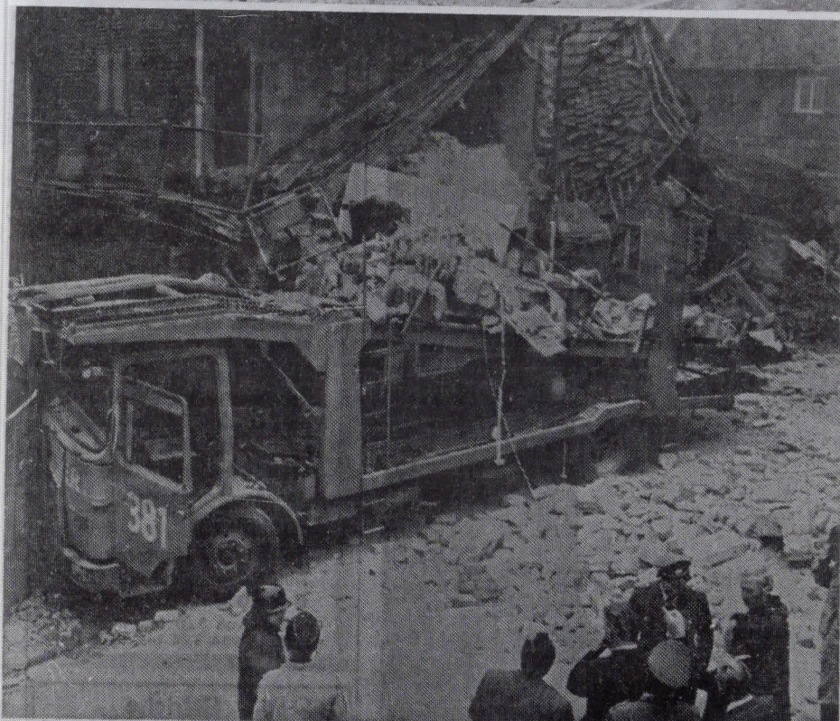
DREI HÄUSER wurden in Nackenheim „Opfer“ eines Lastzuges, der in den frühen Morgenstunden des Donnerstags von der Fahrbahn der Bundesstraße 9 abkam. Die Ortsdurchfahrt mußte für fast den gesamten Tag gesperrt werden. Der Verkehr wurde umgeleitet.
